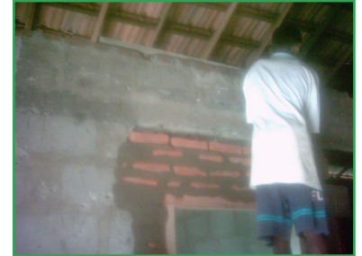
Das Loch in der Mauer ausgefüllt und einen richtigen Türrahmen eingesetzt!
